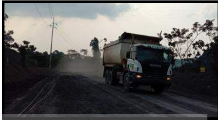
Gambar 4.8 Kondisi jalan hauling yang berdebu
